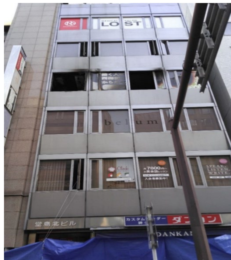
大阪市北区ビル火災 令和3年12月17日発生 死者27名 負傷者1名
