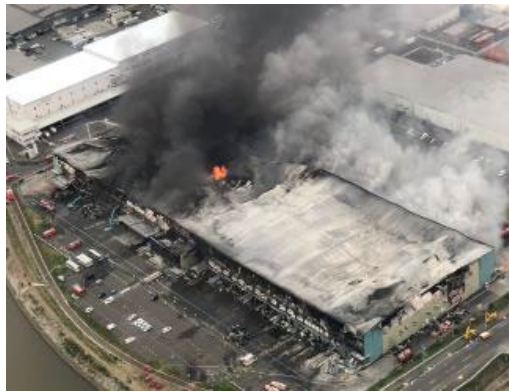
宮城県岩沼市倉庫火災 令和 2 年 4 月 30 日 発生 死傷者なし 焼損面積 約 43,800 m 2
